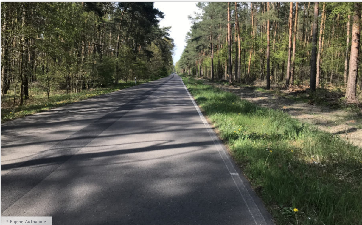
Abbildung 3-24 Beispielhafte fehlende Radverkehrsanlage (T3)
