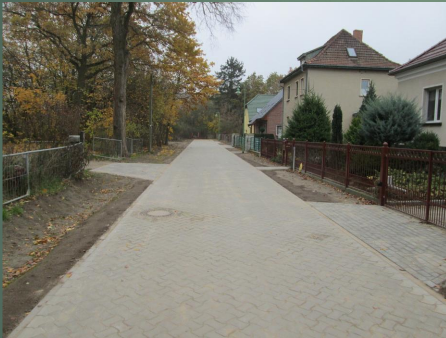
Rosenstraße, Petershagen Pflasterbauweise
