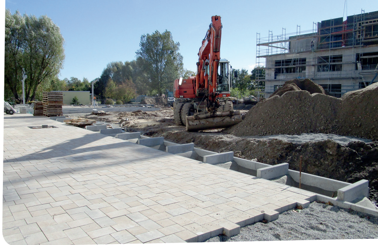
Die Bauarbeiten auf dem Schulhof der Grund- und Oberschule
