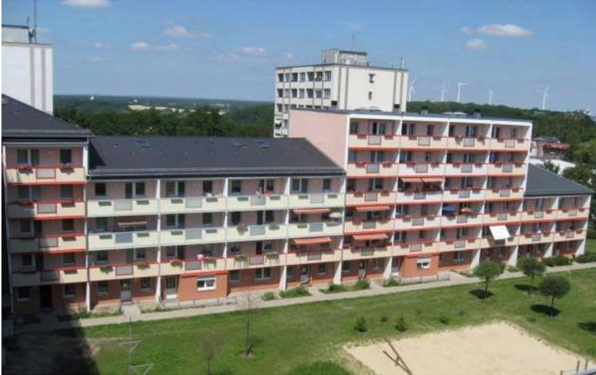
Abbildung 24 - Teilrückgebauter Wohnkomplex Brückenstraße 83-87, 2011 (Quelle: AIC Ingenieurgesellschaft für Bauplanung Chemnitz GmbH. <https://www.aic-chemnitz.de/teilrueckbauund-sanierung-in-ruedersdorf-bei-berlin/> Stand: 21.11.2019.)
