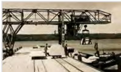
Am Ufer des Stienitzsees gab es eine Verlade-rampe für den Transport per Lastkahn. Hier erfolgte die Verladung mit einem Portalkran. 1931 erfolgte eine Erweiterung des Kalksandsteinwerkes.
